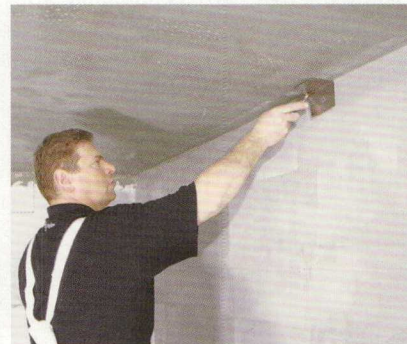
A belső sarkok simításához speciális saroksimítót használunk
