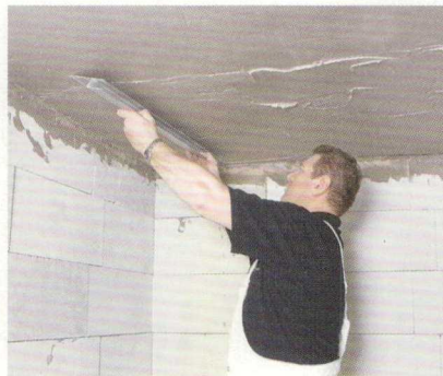
A felhordott Rigips réteget „h” léccel simítjuk el az egyik irányba
