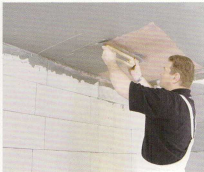
Rigips keverék felvitele a tapadást elősegítő alapcsozóval lekent mennyezetre
