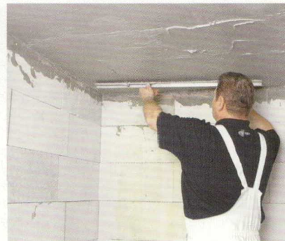
A felhordott Rigips réteget „h” léccel simítjuk el a másik irányba
