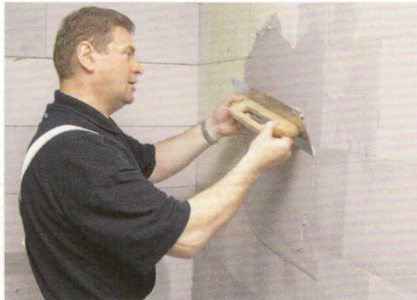
Rigips keverék felvitele a tapadást elősegítő alaplappal lekent falra
