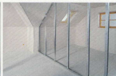
CW-profilok elhelyezése
